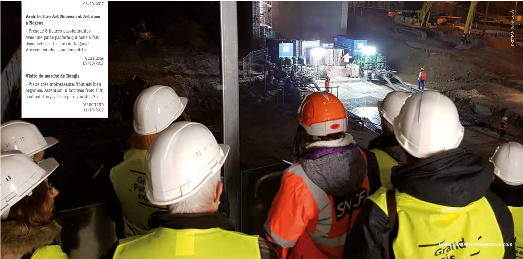
Visite du chantier de ripage du Grand Paris Express
